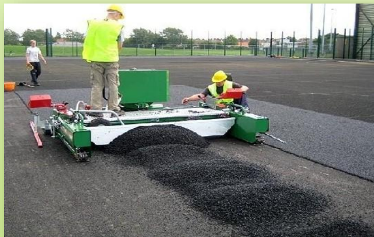
Base elástica extendida "In Situ"
